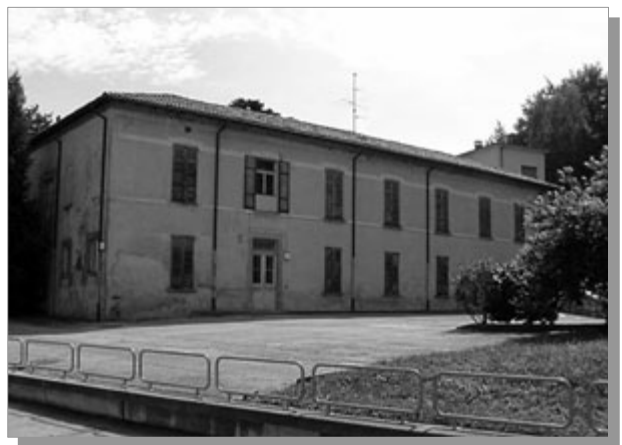
In questo stabile di Mendrisio, situato nei pressi del Liceo Cantonale e della SPAI, dovrebbe trovare posto il Centro Giovanile.
